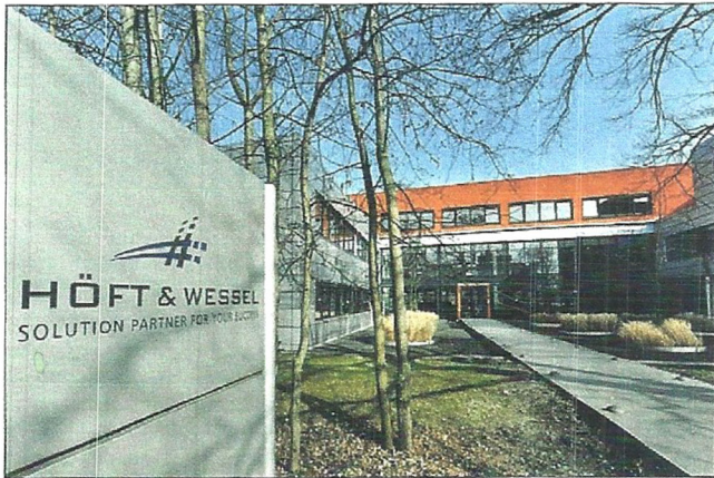
Am Unternehmenssitz in Hannover-Lahe hat die Höft & Wessel AG in vorhandenen Räumen ihr neues „Logistik & Service-Leistungszentrum“ aufgebaut.
